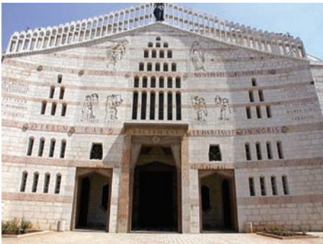
Katolikus Templom, Közép-Kelet legnagyobb keresztény temploma; építését 1968-ban fejezték be.
