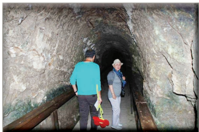
A vízellátási rendszer: 80 m hosszú alagút, amelyen át el lehetett jutni a külső forráshoz.
