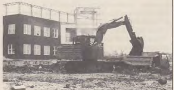
La Cernica, șantierul se grăbește.
