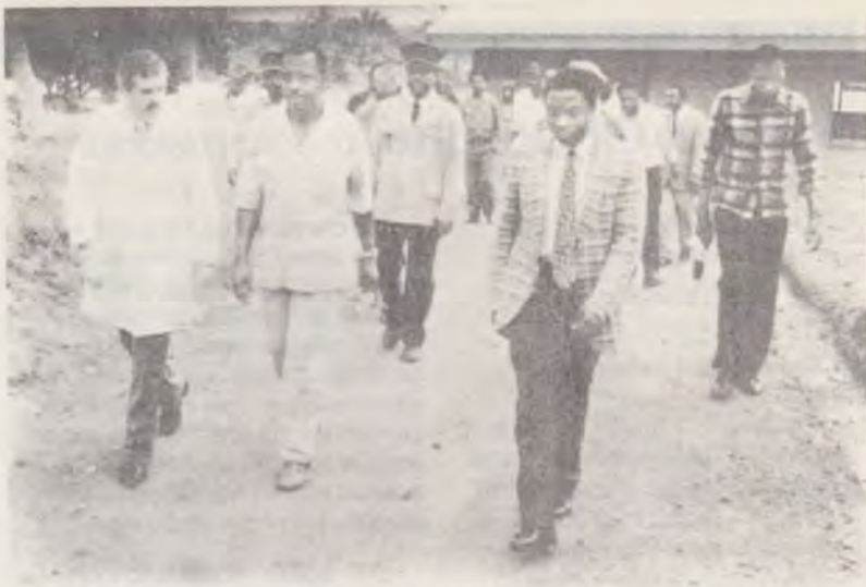
Gubernatorul provinciei în vizită pe șantierul spitalului
