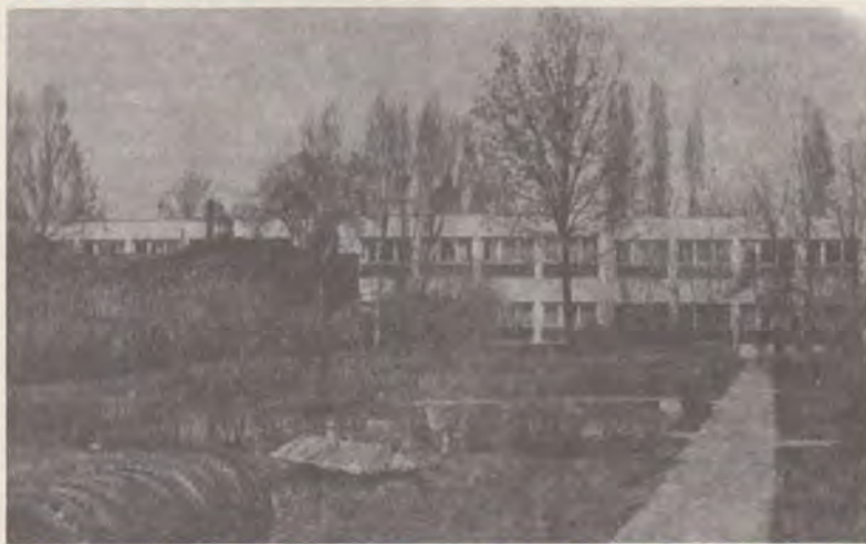
Clădirea din București, cart. Dămăroaia unde va funcționa orfelinatul
