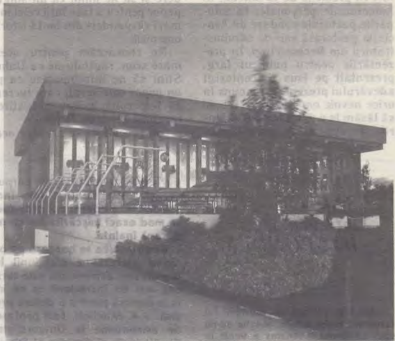
Perth — Clădirea în care s-au ținut lucrările
