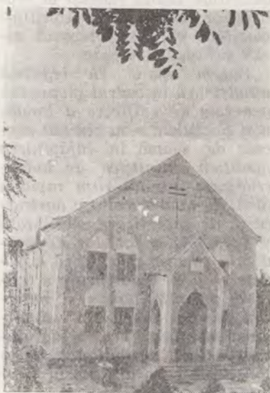
Casa Comunității Crîngeni
