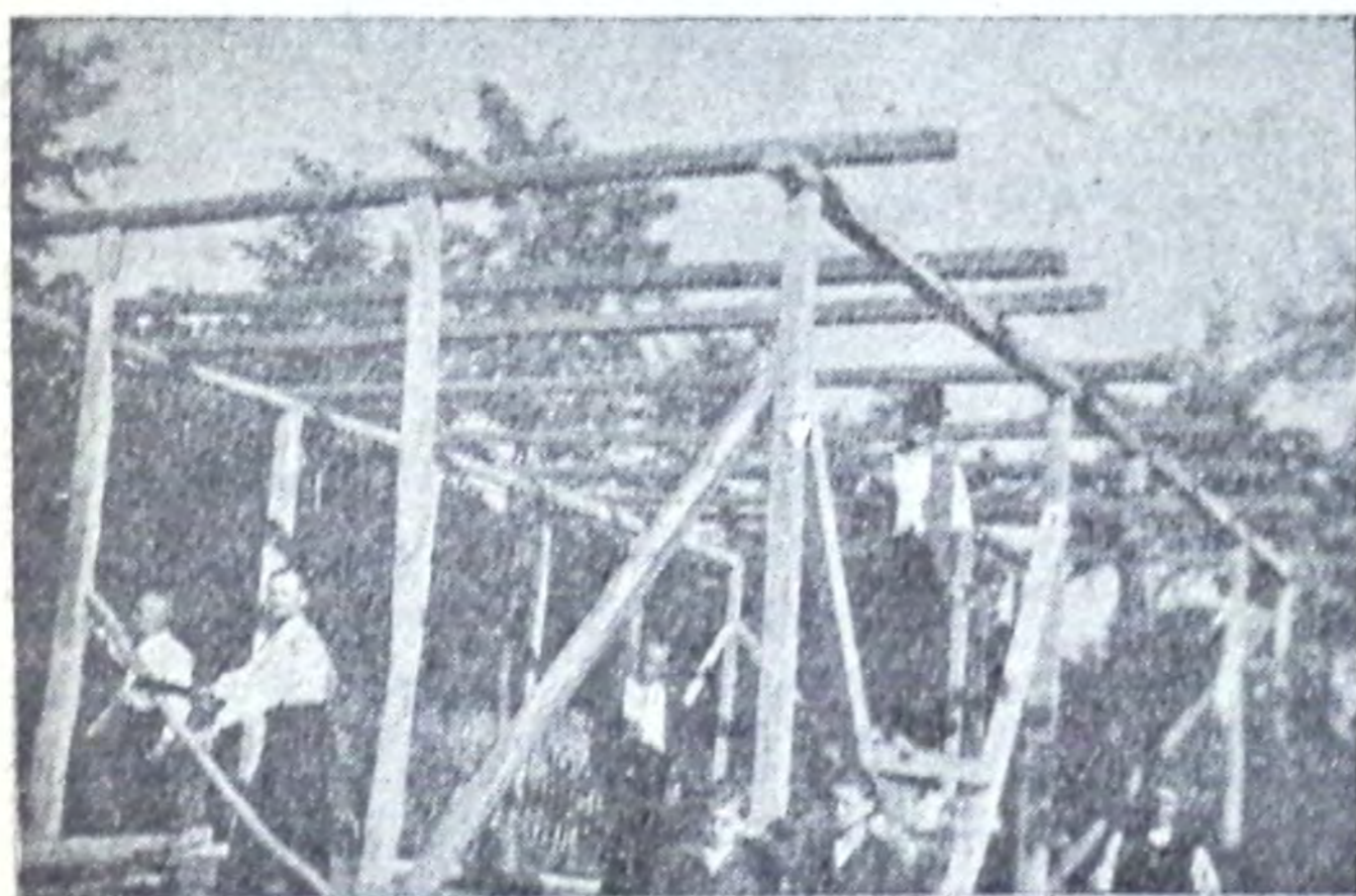
În plină activitate. Construcția casei de rugăciune din Com. Deduilești, R.-Sărat
