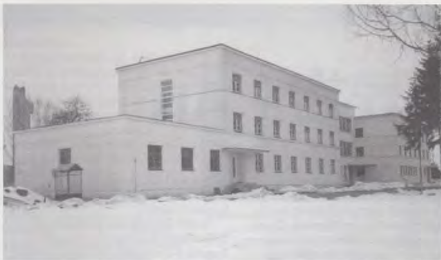
Complexul de la Stupini după renovare
