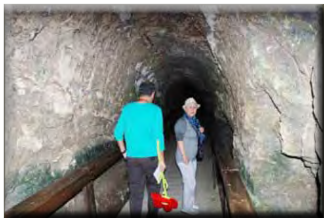
Sistemul de alimentare cu apă, tunelul lung de 80 de metri, care facilita accesul la izvorul din exterior
